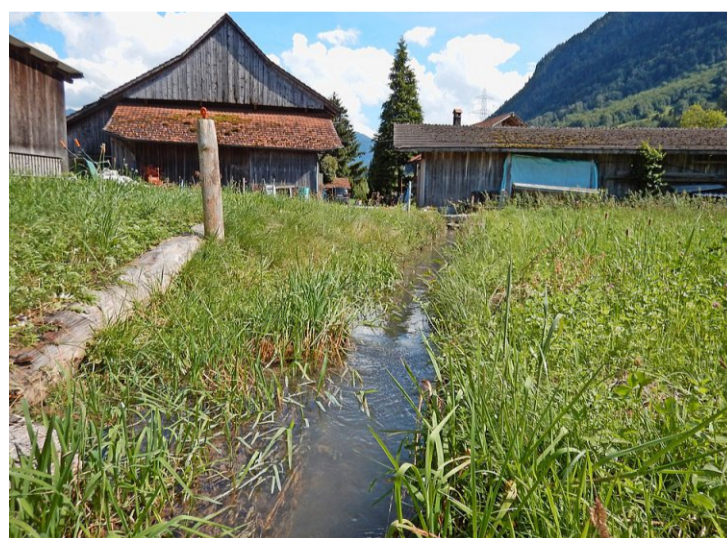
Damit das Aubächli nicht mehr mitten durch Liegenschaften fliesst, wird es an den Waldrand verlegt. Foto: Guido Lauper
